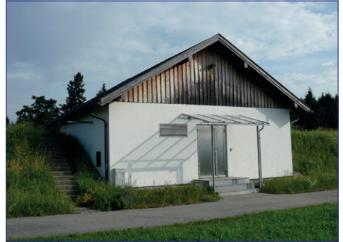
Laufens Wasserbehälter hoch über Froschham. Von dort geht das Wasser an die Verbraucher.
